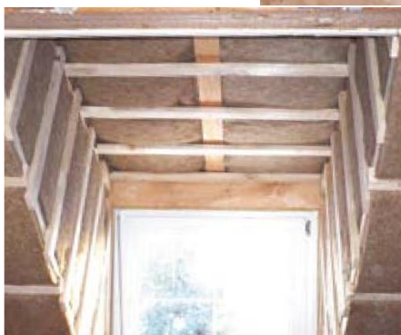
Izolarea unei mansarde, având destinație de locuință.
