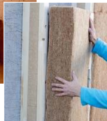
Izolație exterioară: THERMO FASSADE cu THERMO JUTE 100
