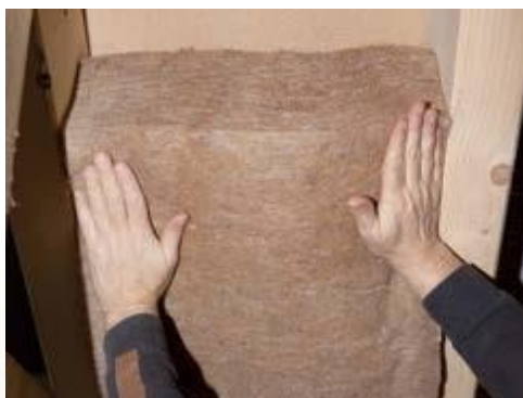
Izolația mai lată e montată cu ușurință.
